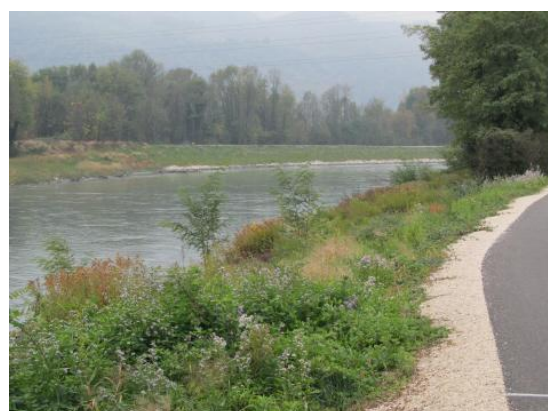
Enrochement dans les courbes du cours d'eau.
